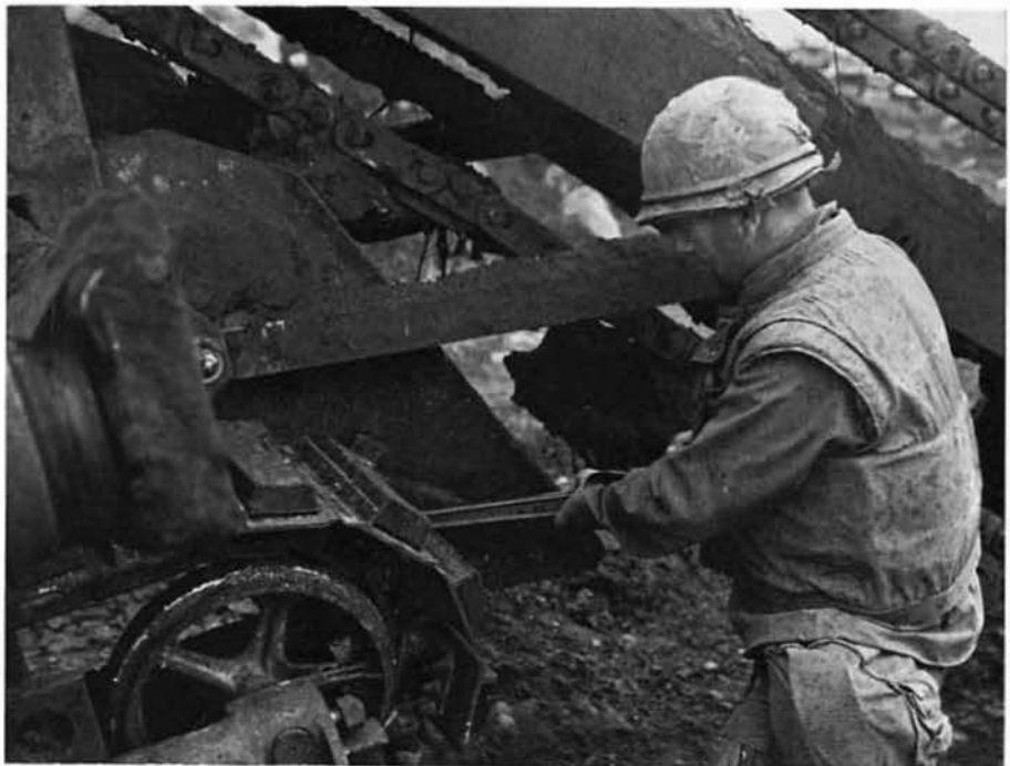
CMH2 GRENIER repairs the trencher at Con Thien.
