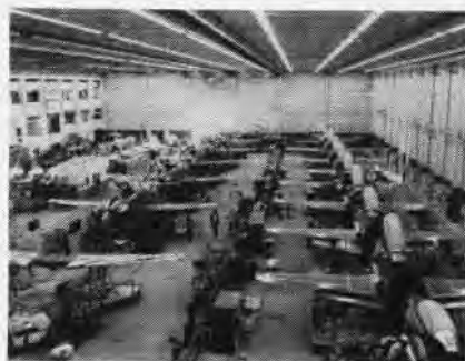
TV-2, T-33 JET TRAINER ASSEMBLY LINES
